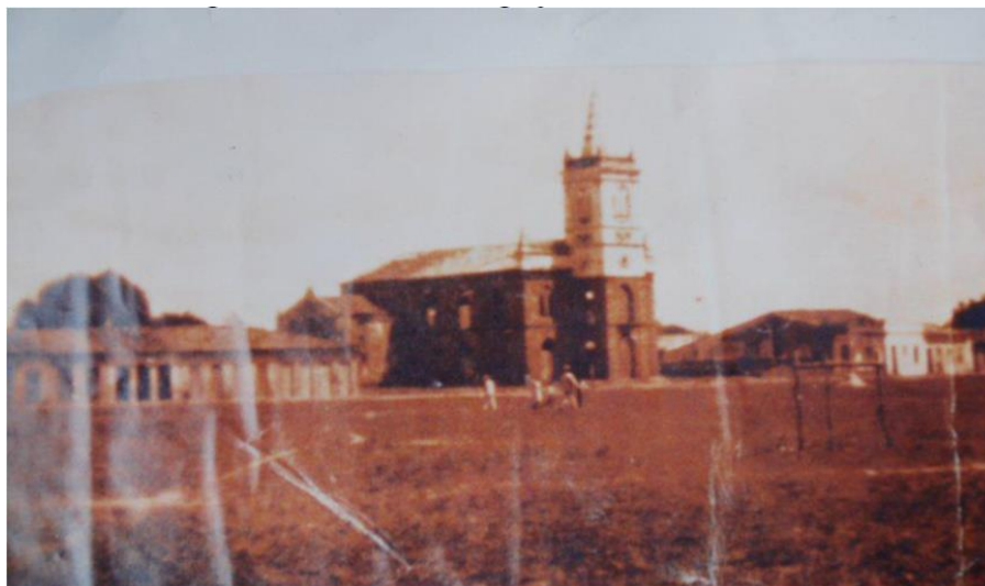
Figura 18: Fotografia da capela em construção do Santíssimo Coração de Maria
