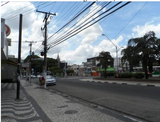
Figura 59 – Reorganização das vias, depois da retirada do terminal de ônibus urbano do centro da cidade, para melhoria do trânsito na Avenida Getúlio Vargas (2014)
