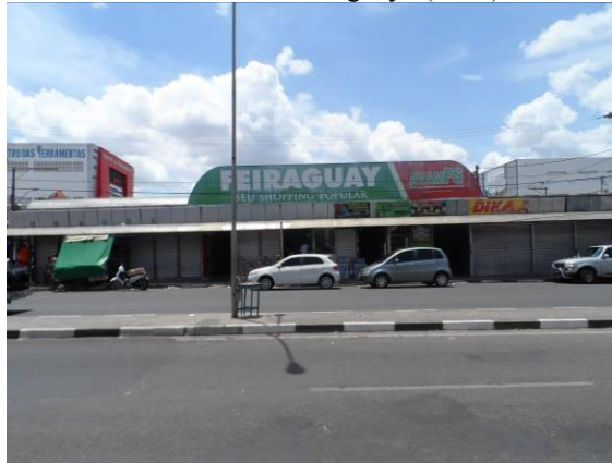
Figura 47 – O prédio foi demolido e hoje está localizado o “Feiraguay” (2014)
