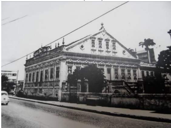
Figura 54 – Residência de João Marinho Falcão, na esquina da Rua Senhor dos Passos com a Praça Bernardino Bahia, construída no início do século XX (1970)
