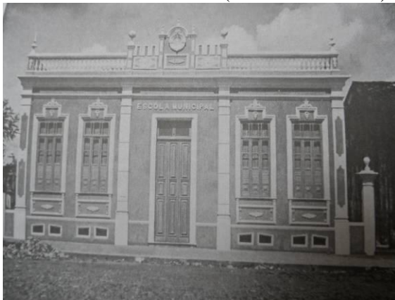
Figura 24 – Escola Municipal, localizada na Avenida Senhor dos Passos (início do século XX)
