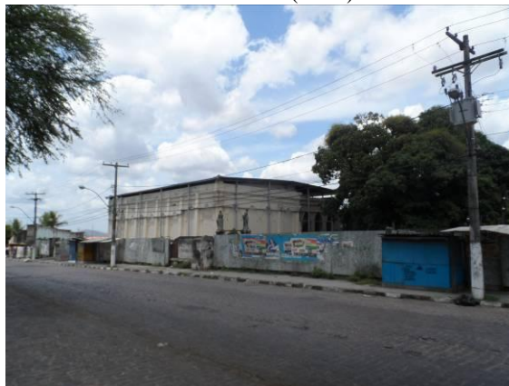
Figura 21 – O prédio já foi Hospital, Quartel da Polícia Militar e abrigo para menores. Hoje é conhecido como Palácio do Menor e está abandonado (2014)
